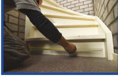
Meet de afmetingen van het onderste stootbord op. Hoogte: meten vanaf de vloer tot de onderkant van de eerste trede. Lengte: meten van links naar rechts.
