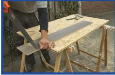
Zaag het stootbord, aan de decor zijde, met een hand- of decoupeerzaag secuur op maat uit. Schuur eventueel de zaagranden glad met een fijn schuurpapiertje voor een nette afwerking.
