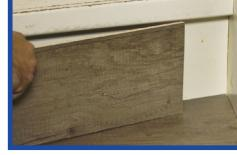
Druk het stootbord tegen de achterkant van de trap aan. Laat dit enkele minuten goed drogen. Vervolgens lijm u de onderste overzettrede in, conform de leginstructie in de verpakking hiervan. U lijm dus telkens eerst het stootbord in en daarna pas de volgende trede! Meet het volgende stootbord op, waarbij u de hoogte meet vanaf de overzettrede tot de onderkant van de volgende trede. Herhaal stap 2 t/m 6 totdat u alle stootborden en treden heeft gehad.
